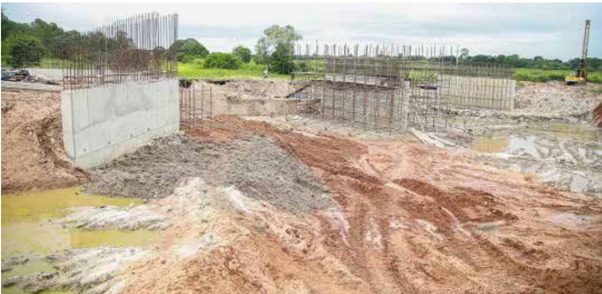
Ujenzi wa Daraja la Mbambe Halmashauri ya Wilaya ya Rufiji
