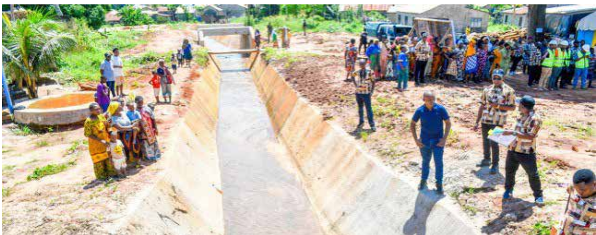
Ujenzi wa Mfereji wa Maji pamoja na Boksi Kalavati Halmashauri ya Wilaya ya Kibiti
