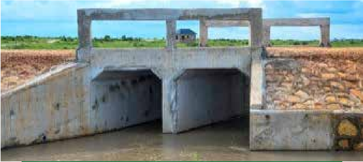
Ujenzi wa Boksi Kalvati barabara ya Kilangalanga - Mwanabwito
