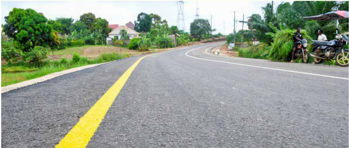
Ujenzi wa Barabara ya Picha ya Ndege - Sofu kwa Kiwango cha Lami Manispaa ya Kibaha
